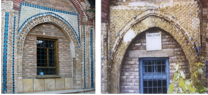
Fotoğraf-3: Cemal Ali Dede Türbesi ön cephe çinileri ve boya uygulamalar, 2008.
