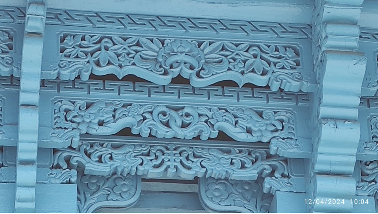
Resim 16. Çatının hemen altı. (B. Kabakçı,2024)
